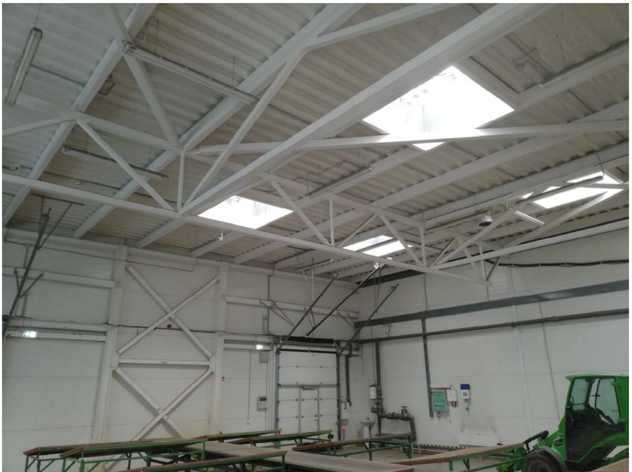
14 pav. Pietinio tūrio stogo konstrukcijų fotografacija
