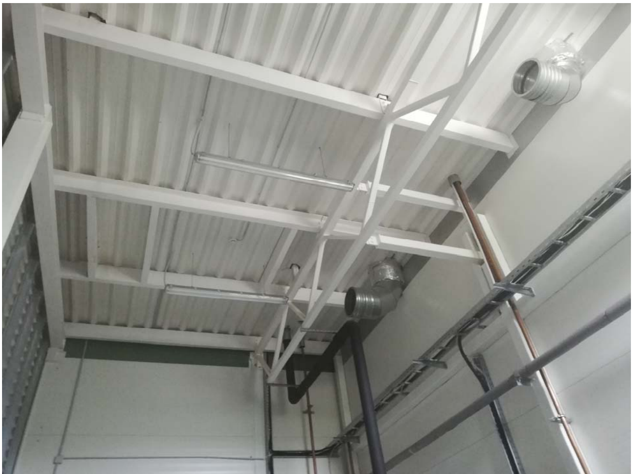
10 pav. Šiaurinio tūrio stogo konstrukcijų fotofiksacija
