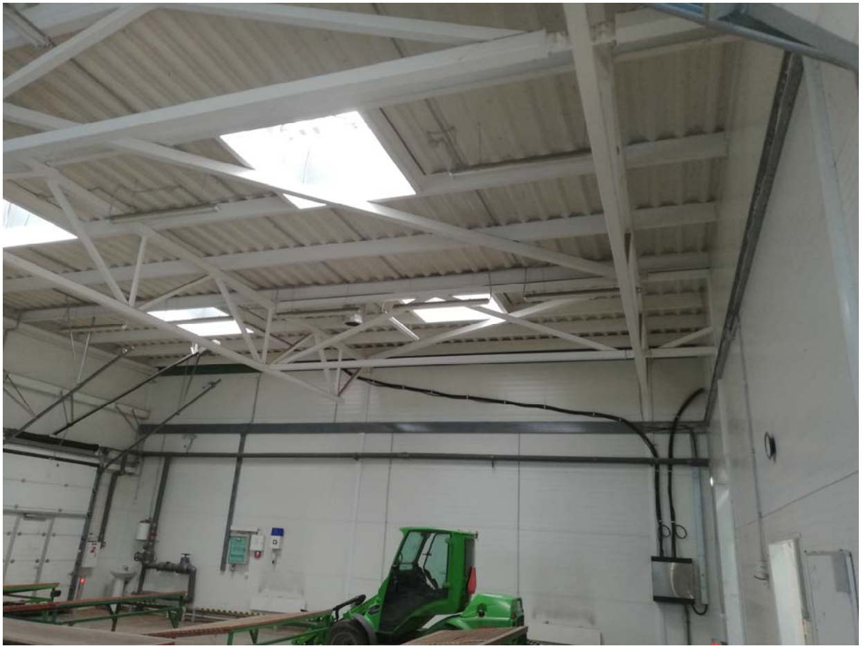
13 pav. Pietinio tūrio stogo konstrukcijų fotografacija
