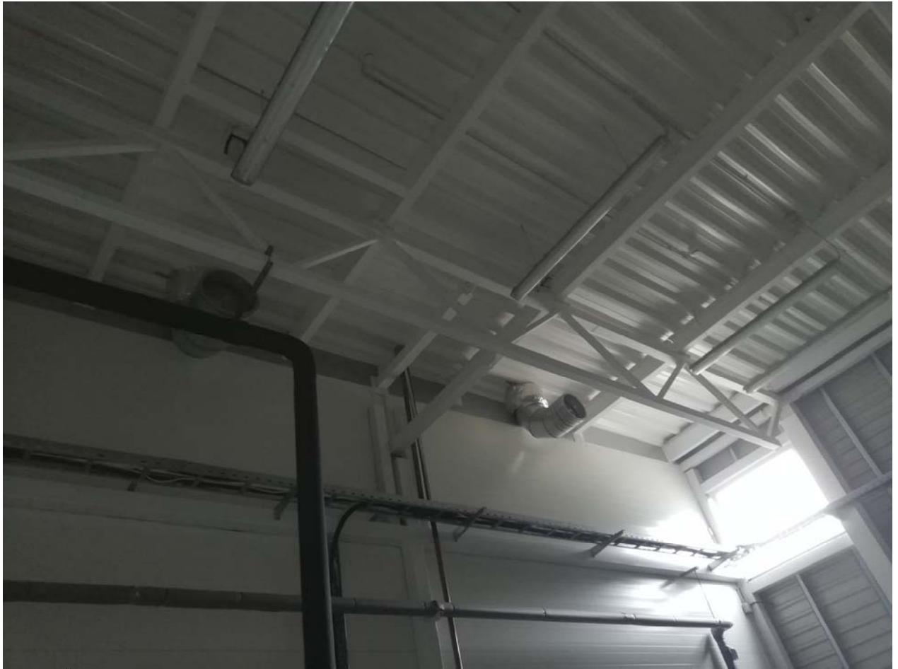
09 pav. Šiaurinio tūrio stogo konstrukcijų fotofiksacija
