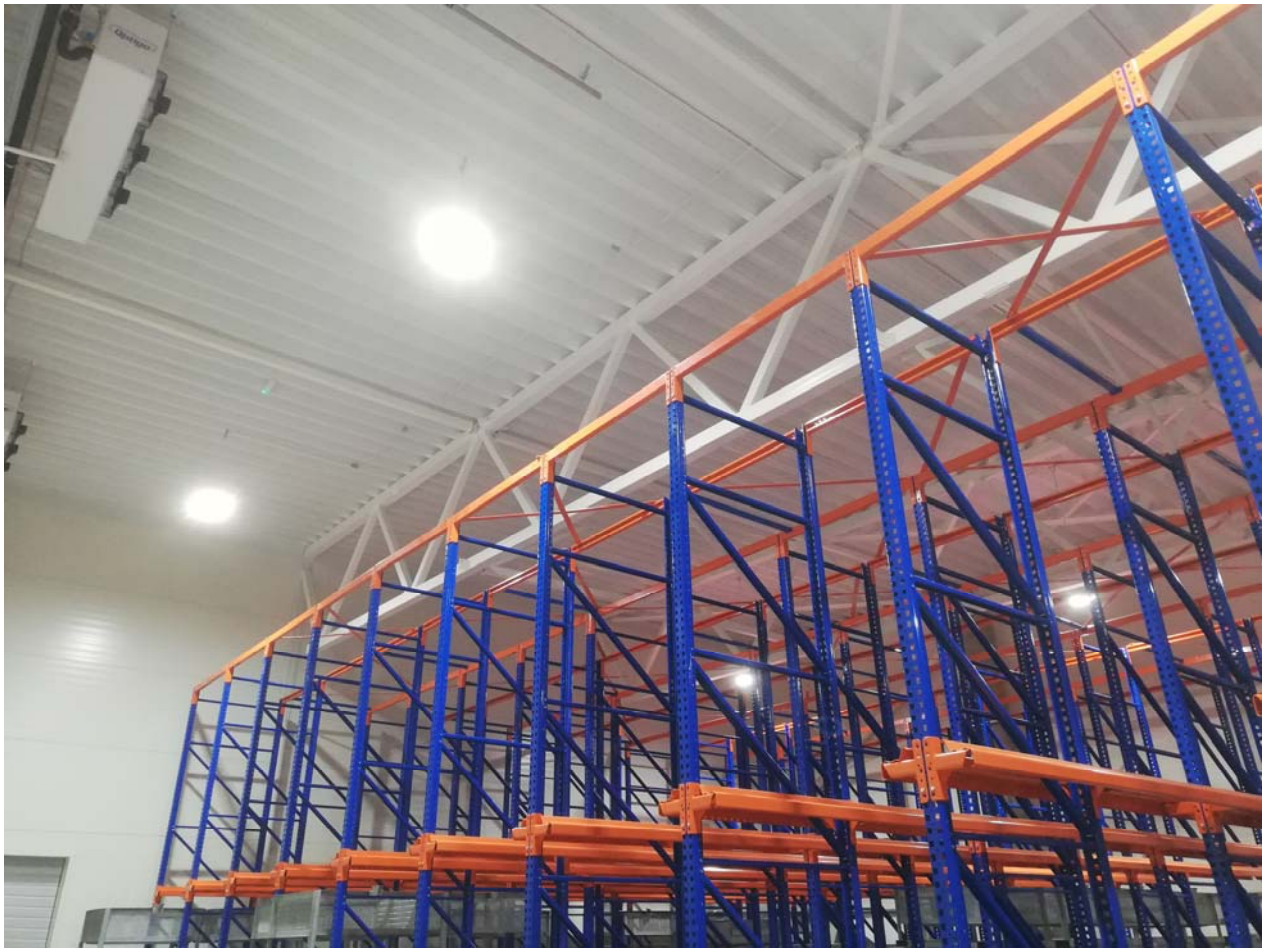
11 pav. Centrinio tūrio stogo konstrukcijų fotofiksacija
